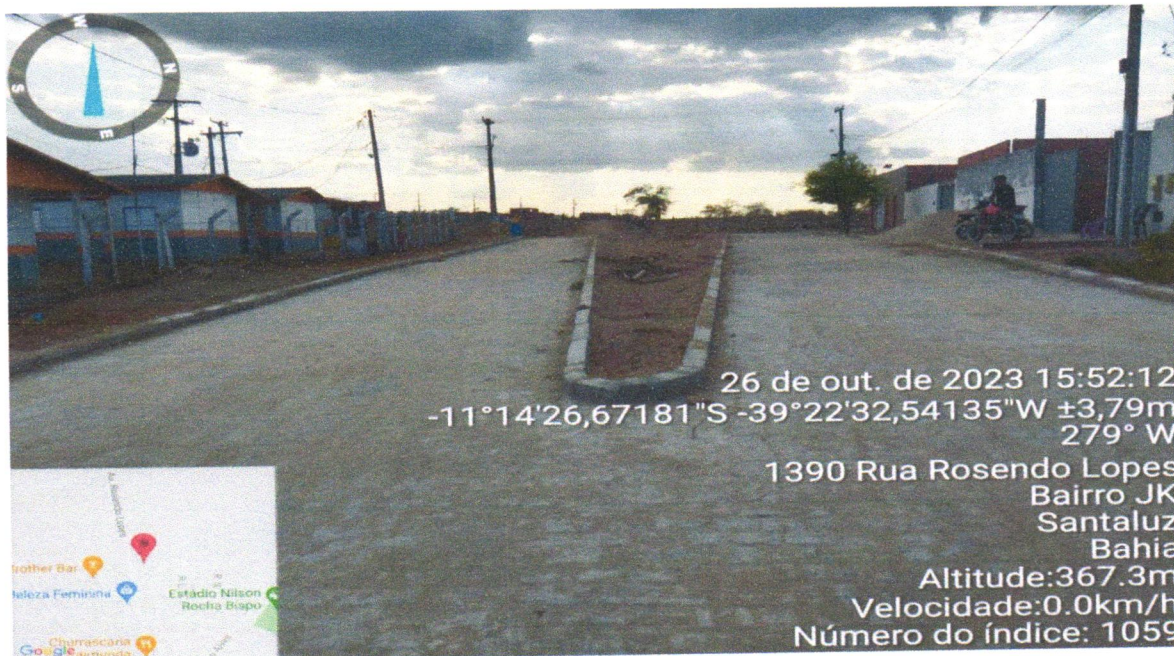
Execução de Pavimentação do Bairro JK, Rua Projetada 01 Trecho III e IV
