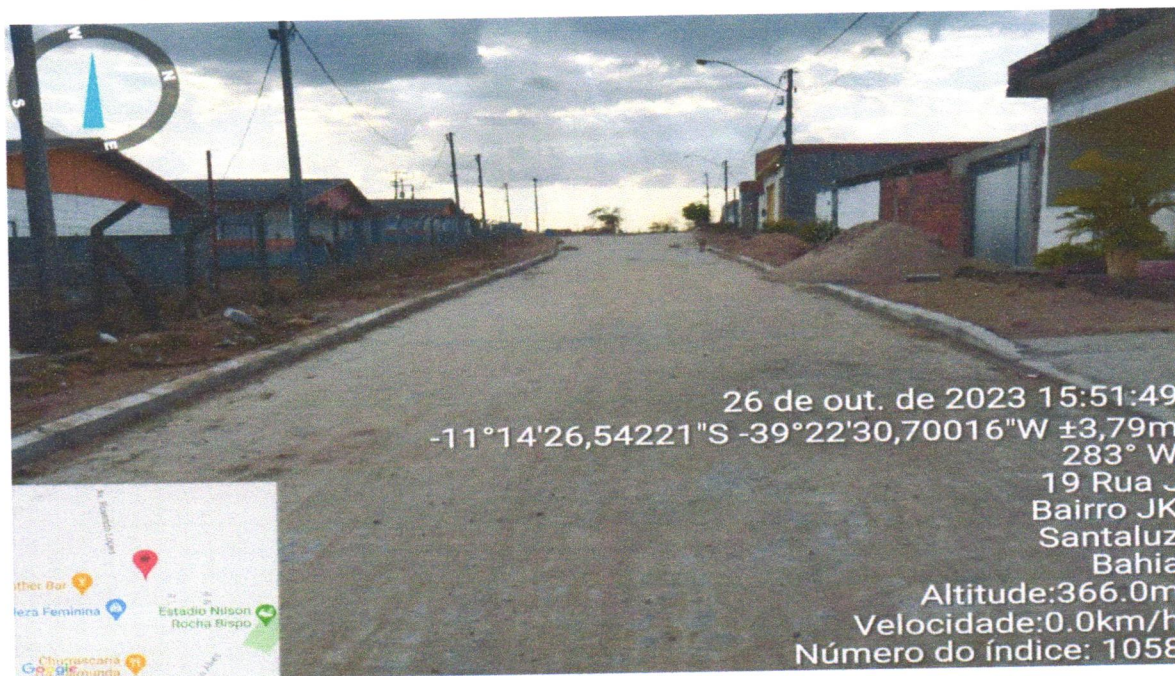
Execução de Pavimentação do Bairro JK, Rua Projetada 01 Trecho I
