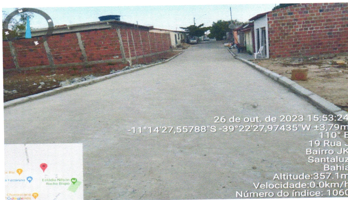
Execução de Pavimentação do Bairro JK, Rua Projetada 03
